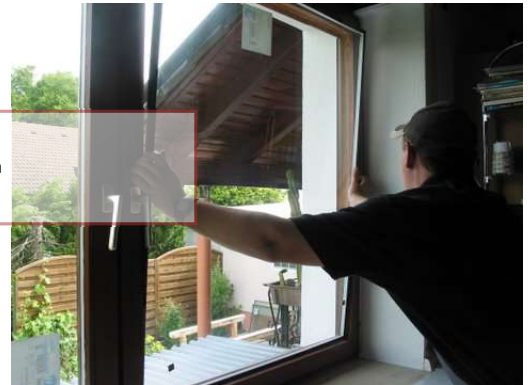
Verglasen der neuen, energetisch verbesserten Isolierglasscheibe
