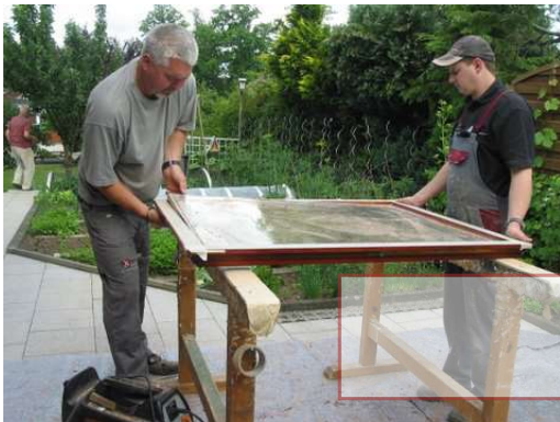
Demontage der alten, im Kittbett verlegten Bestandsscheiben
