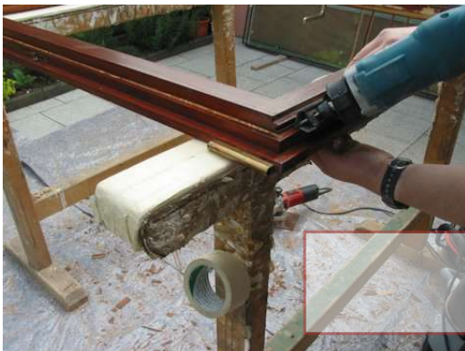
Einfräsen der Dichtungsnut
